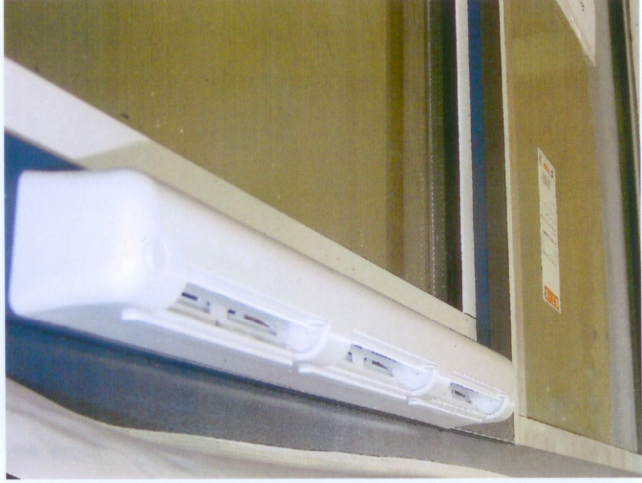
Фото 3. Установленный приточный вентиляционный клапан «Ventec VT701» (в открытом положении)
